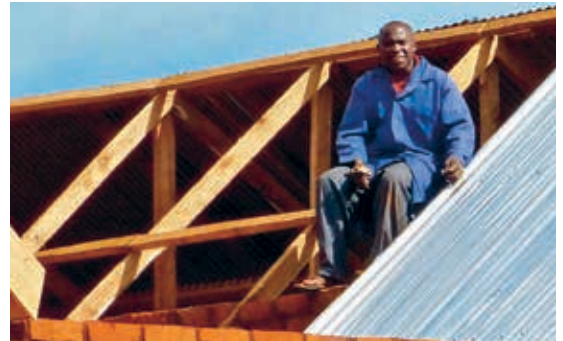
Das Kita-Dach in Mbinga wird gedeckt. Foto: Uwe Feulner
